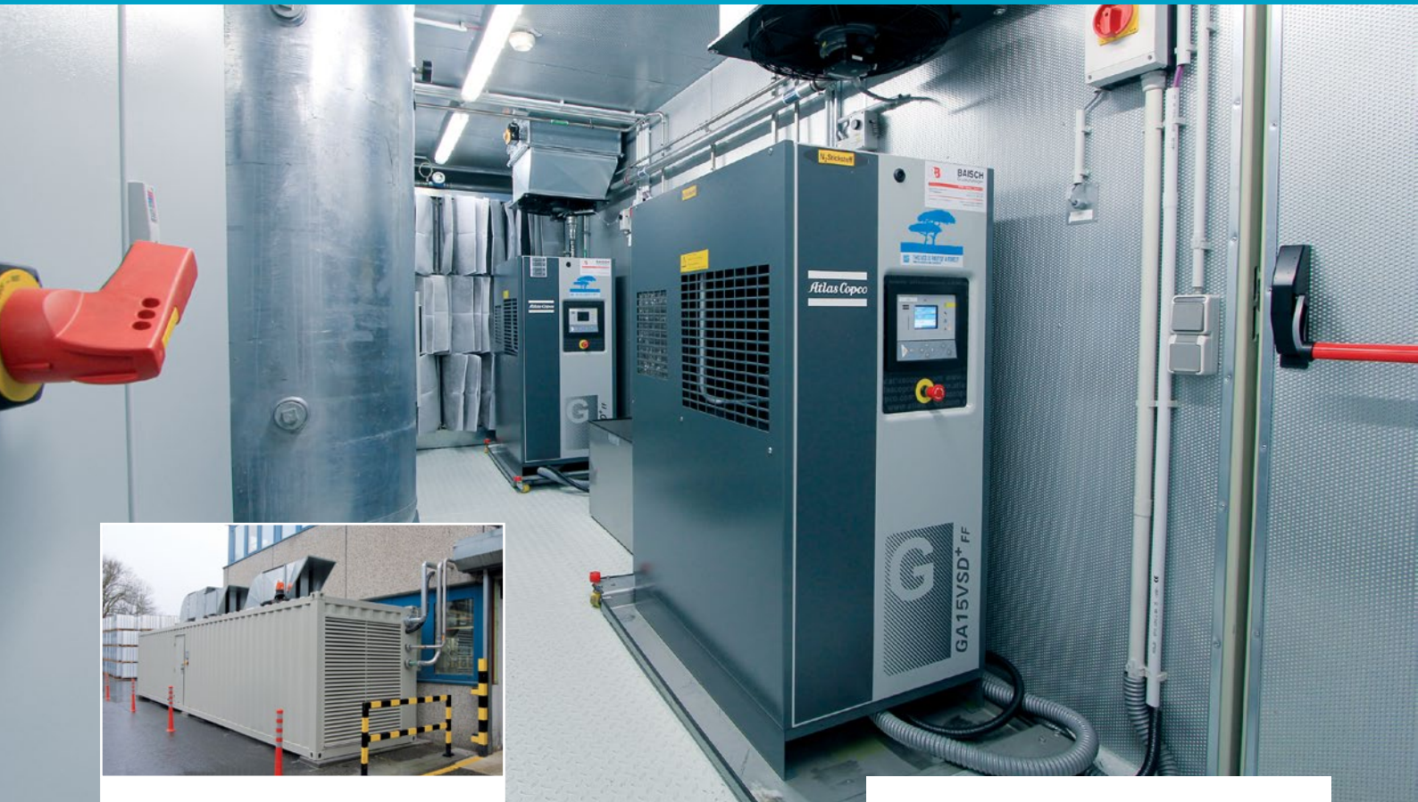
Der Container war schnell installiert: Er wurde nur an das Druckluftnetz angeschlossen.
