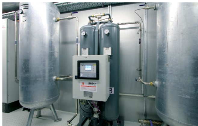
Die Stickstoffgeneratoren des Typs NGP 15 von Atlas Copco arbeiten nach dem Prinzip der Druckwechseladsorption. Das ist effizienter als die Stickstoffherzeugung über Membrananlagen.
