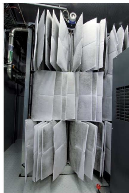
Nahaufnahme der Kulissenschalldämpfer mit Pollenfilter.
